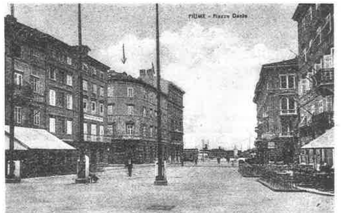
Le due case demolite in Piazza Dante.
