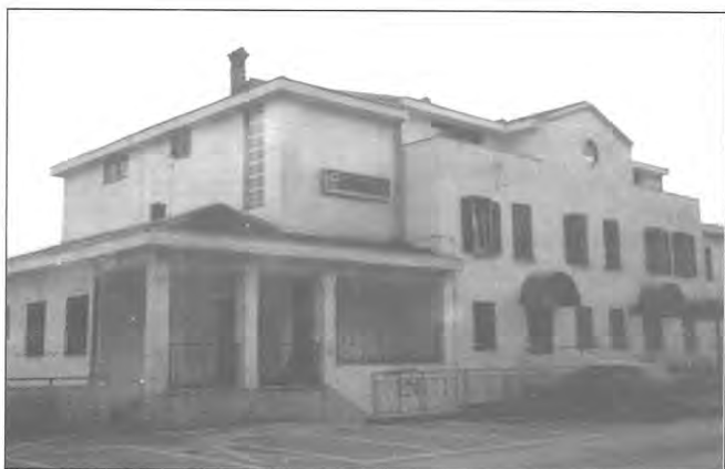
L'ex centrale di Punta Colova... .. oggi riciclata e irrecognoscibile (e trasformata in una casa di villeggiatura).
